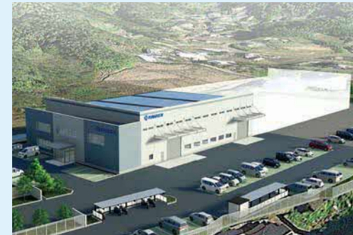
2023年10月頃に熊本工場が竣工(写真は完成イメージです)
