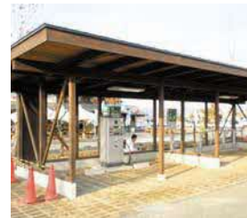
充電ステーション
